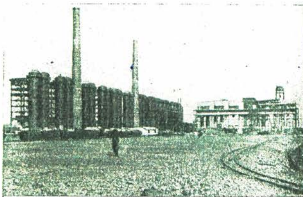
Usine de Belval Construction de la centrale électrique (1910)
