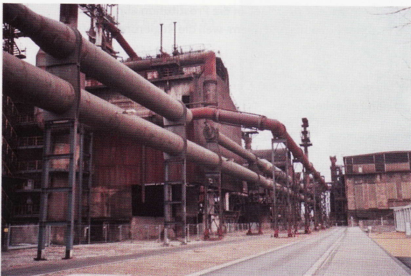
Gas- an Héichuewewandleitungen tëschent der Gebléisszentral an dem Uewen A, ewéi se och nach elo do stinn ( Mee 2015)
