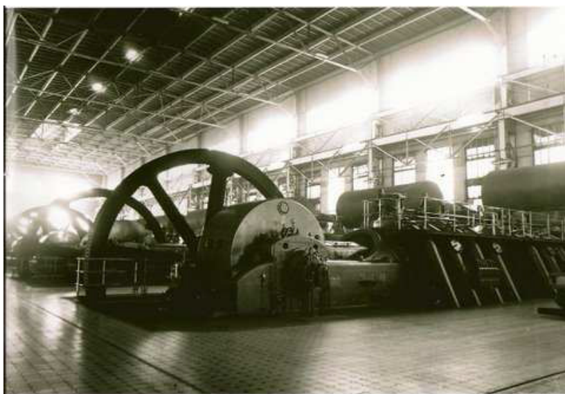
Foto 2: Gebléissentral mat 9 Gichtgaskolbegebléiss an 1 Dampurbogebléiss (Vue vun der Maschineschwongradsäit opgeholl)
