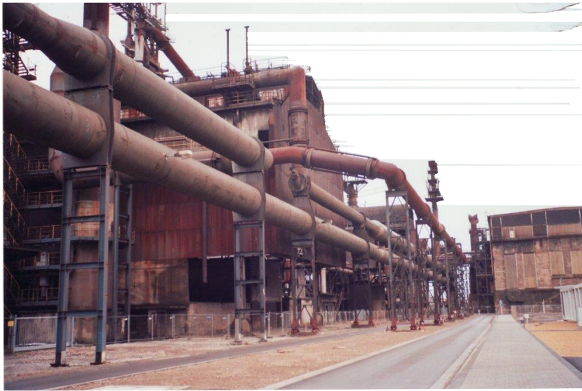
Foto 5: Gas- an Héichuewandleitungen téschent der Gebléisszentral an dem Uewen „A“, ewéi se och nach elo do stinn.
