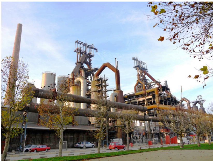
Foto 3: 23.11.2011: D'Héichuewen A & B virum Antikorrosiouns- traitement
