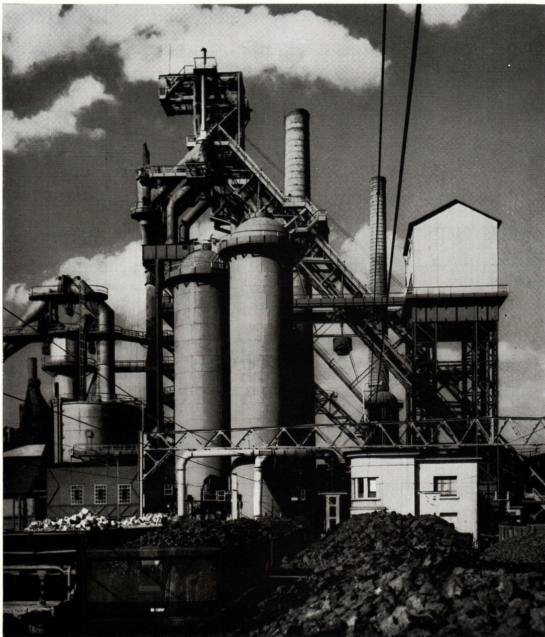
USINE d'ARBED-ESCH • HAUTS FOURNEAUX
