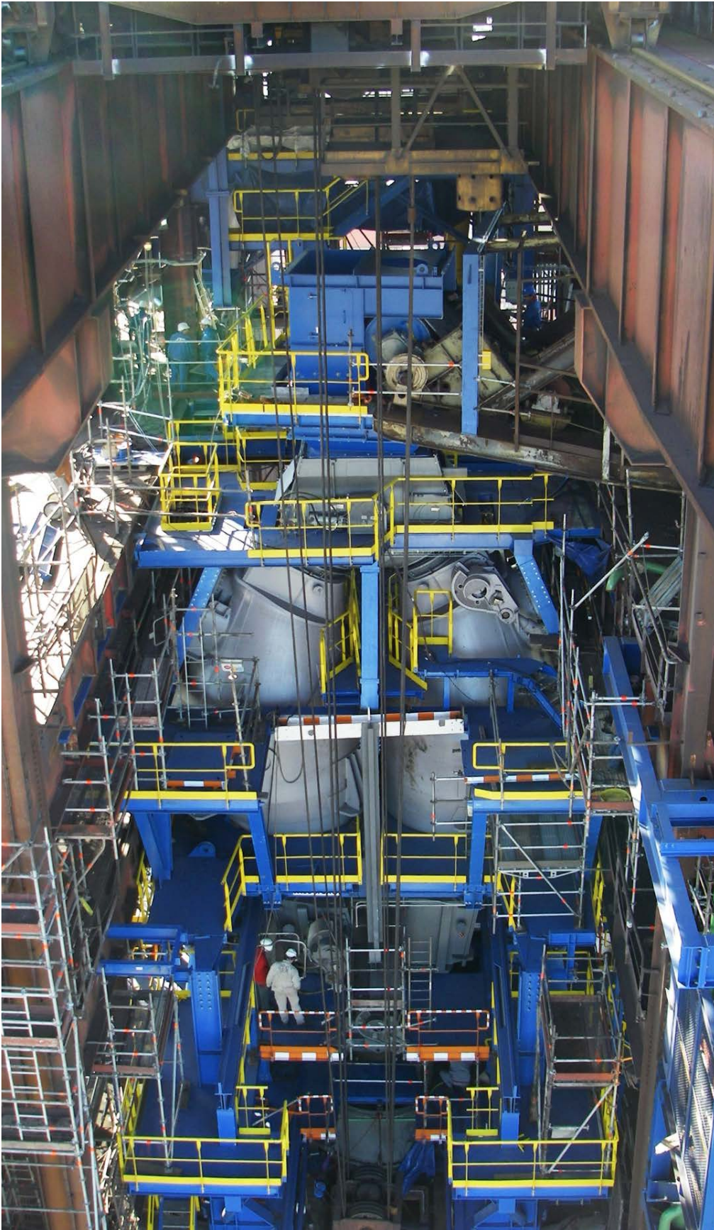
Montage eines glockenlosen Gichtverschlusses am HO1 von ArcelorMittal Méditerranée (September 2008)
