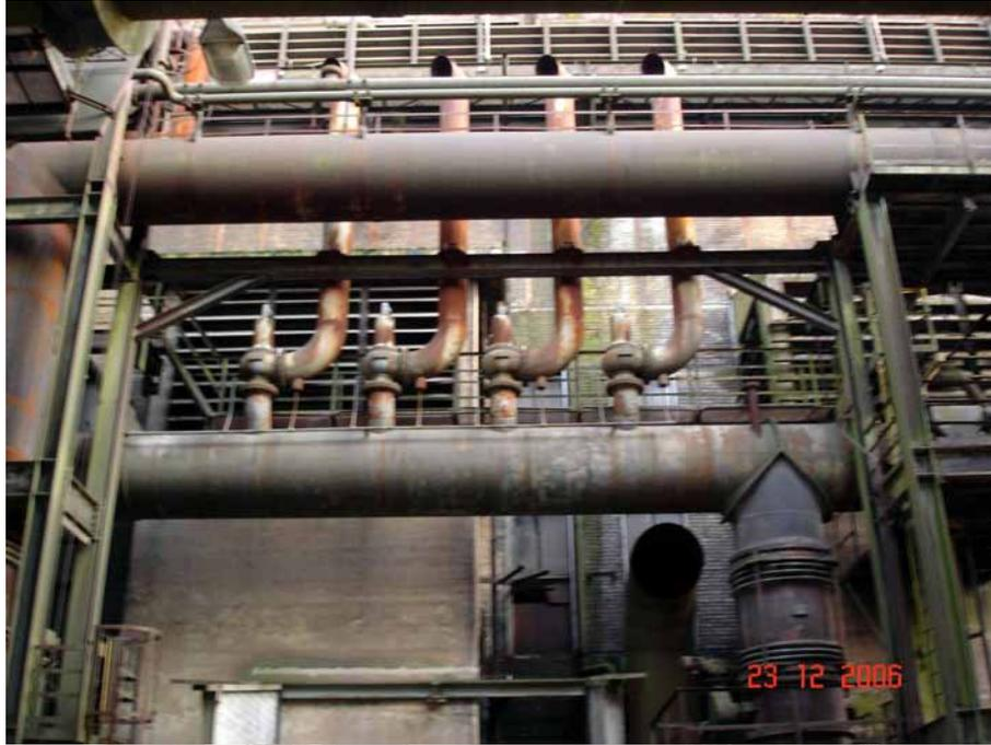
Image: Les soupapes de sécurité à la sortie de la salle des soufflantes.
