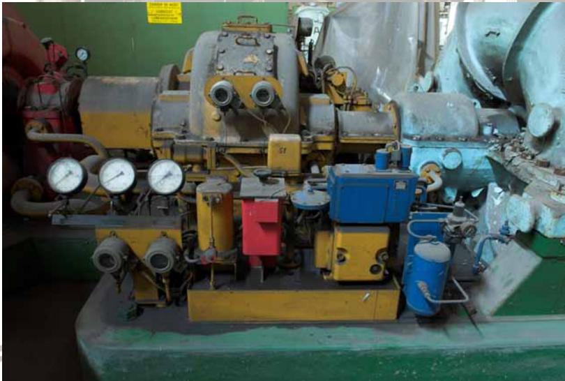
Image: Accouplement soufflante avec graissage des palliers
