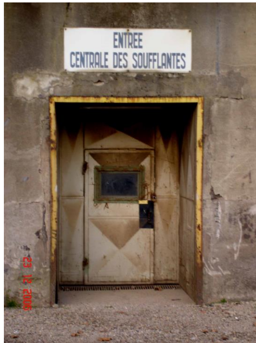
Image: Porte d'accès à la centrale des soufflantes
