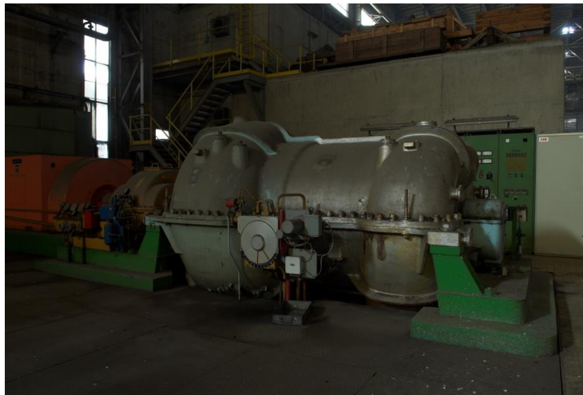
Image: Soufflante = Turbocompresseur.
