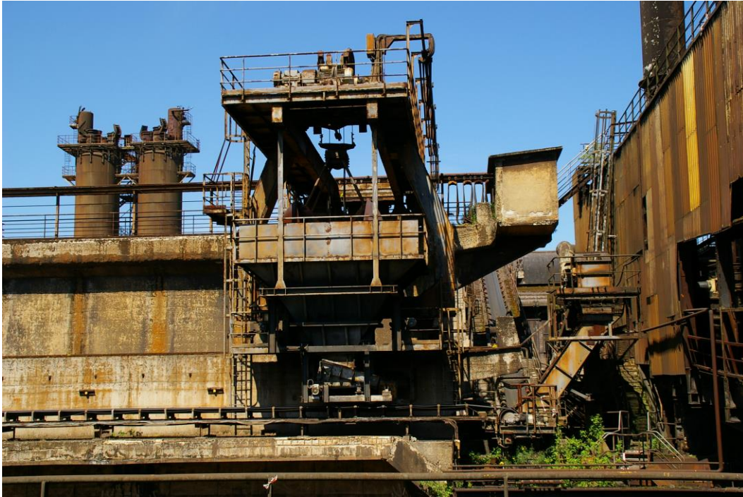
Image: Le pont à grapin avec entonnoir et bande transporteuse de gravier du HF “B”.
