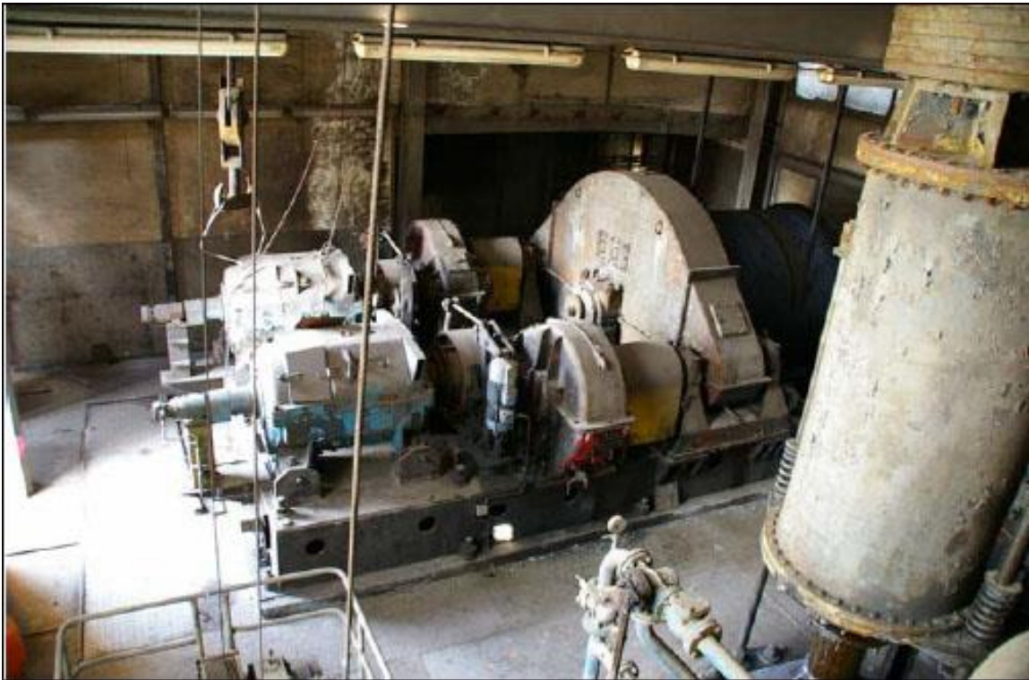
Image: Treuil de skip du HF "A".
