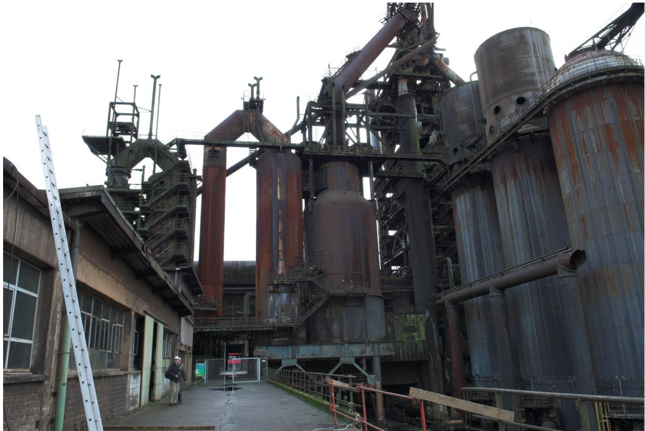
Image: Le Highway, artère de circulation sur le site des HFx.
