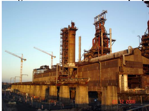
Image: Batiment des silos de la préparation de la charge du HF “A” et “B”
